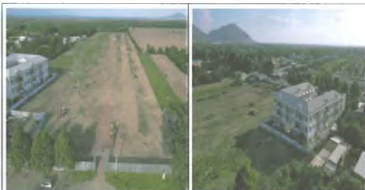
Mặt bằng hiện trạng dự án đã được phát quang mặt bằng, lắp đặt hàng rào tôn
