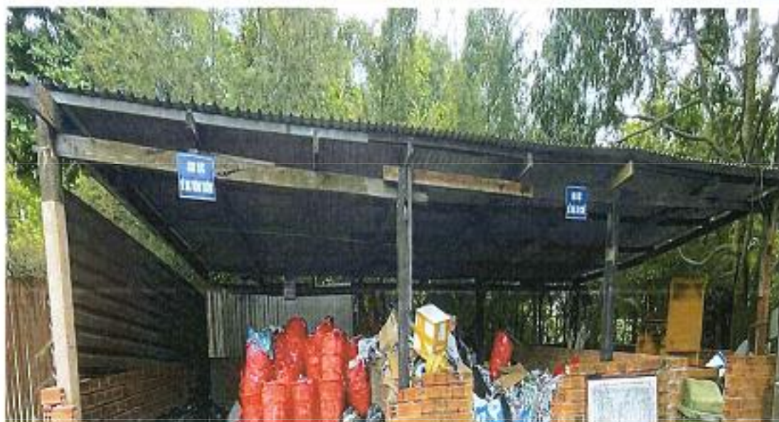
Hình 3.6. Khu vực kho tập kết chất thải thông thường
