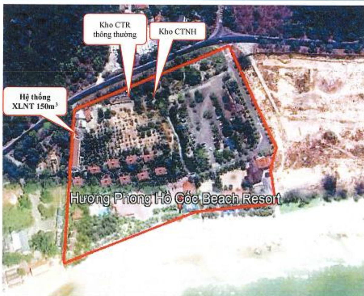
Hình 1.3: Hình ảnh tổng thể hiện trạng các công trình của cơ sở
