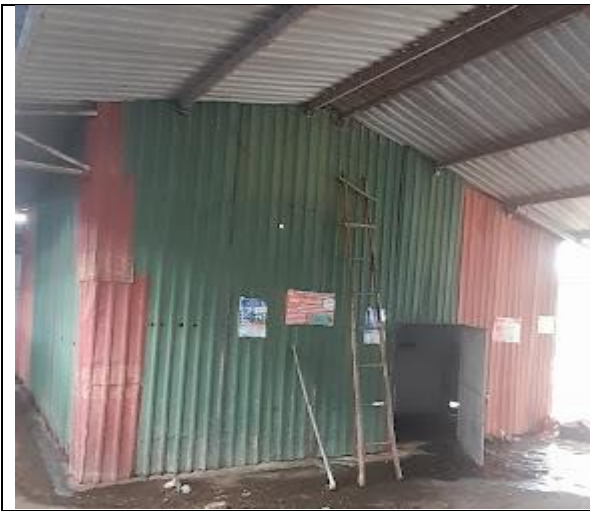
Khu vực hệ thống xử lý nước thải cs. 20m 3 /ng.đ
