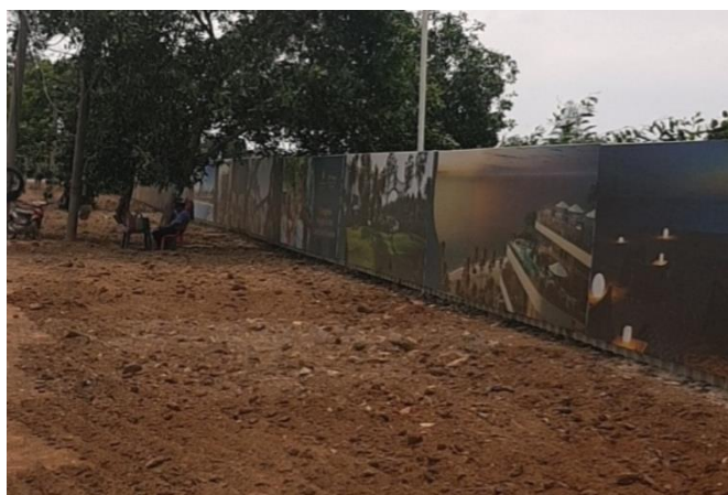
Tấm vây bằng tôn cách ly công trình với khu vực xung quanh ( Minh họa)
