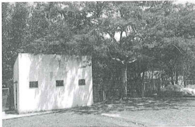
Hình 3. 8 Nhà vệ sinh tại Phân xưởng sản xuất thuốc nổ ANFO
