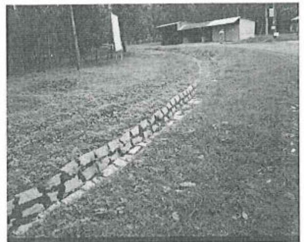
Hình 3. 6 Hệ thống rãnh thoát nước dọc tuyến đường vận chuyển nội bộ
