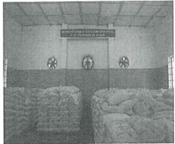
Hình 3. 9 Quạt hút và đẩy tại phân xưởng sản xuất thuốc nổ ANFO
