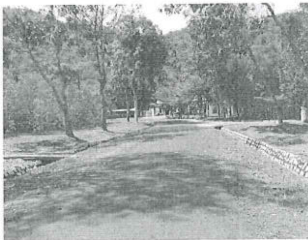
Hình 3. 6 Hệ thống rãnh thoát nước dọc tuyến đường vận chuyển nội bộ
