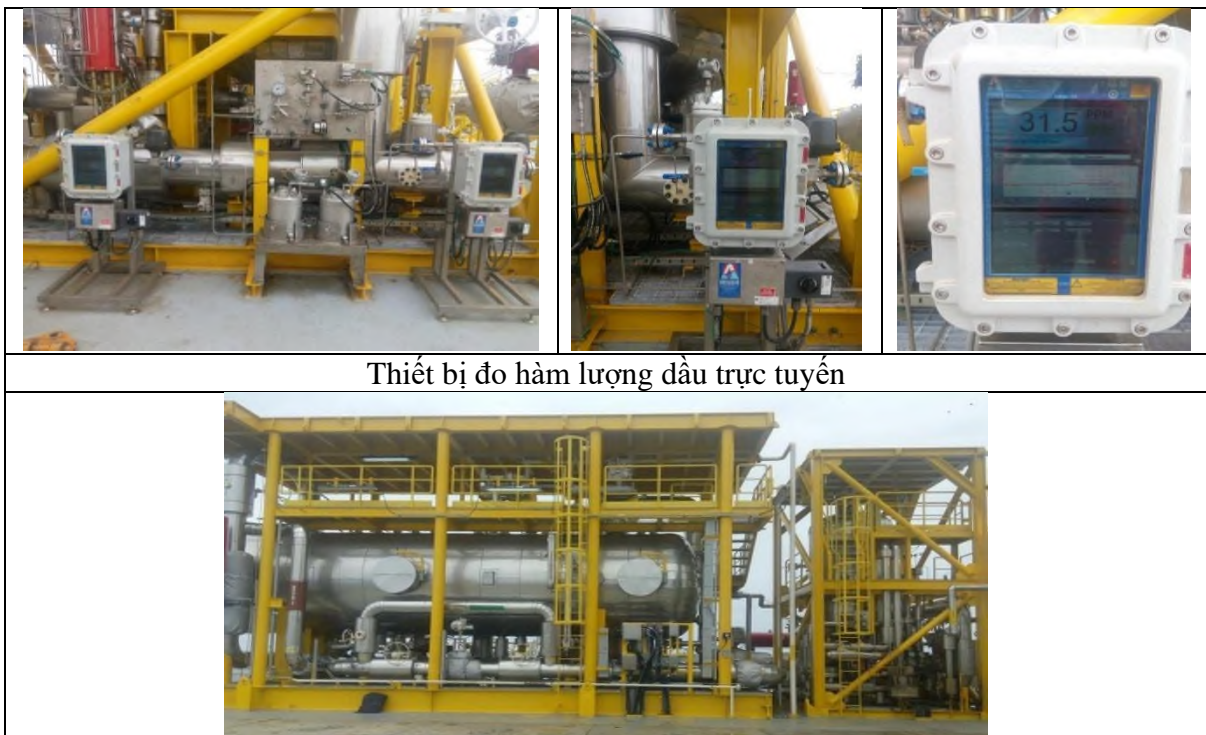
Hình 3.26 Hình ảnh hệ thống xử lý nước khai thác trên giàn H1-WHP
