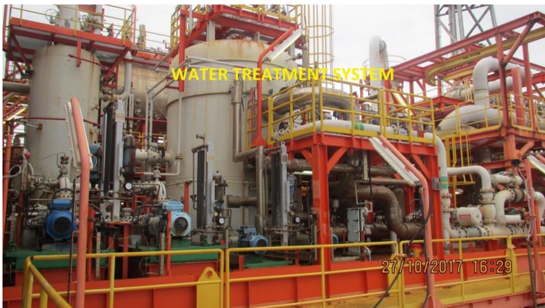
Hình 3.28 Hình ảnh hệ thống xử lý nước khai thác trên tàu FPSO Armada TGT1
